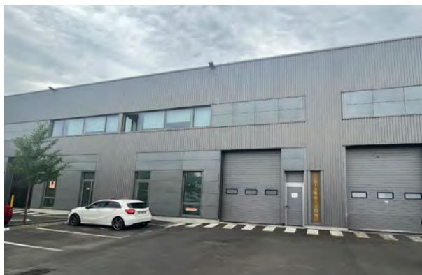
Locaux d'activité - Stains
